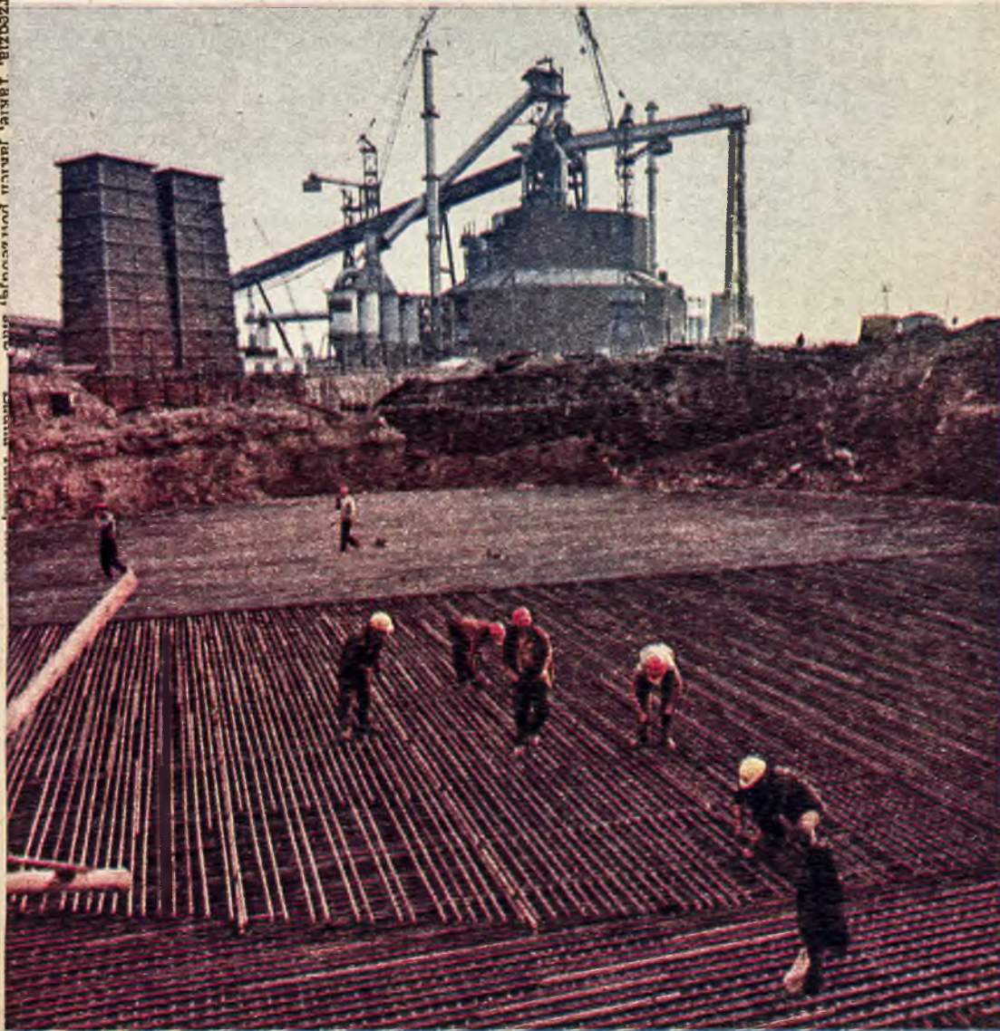
Brygada zbrojarska Henryka Kołodzieja z Budostolu-1 podczas zbrojenia fundamentu pod drugi wielki piec
