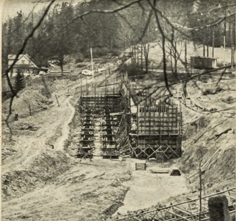
Rozpoczęła się budowa ośrodka czasowego „Orle Gniazdo” w Szczyrku.
