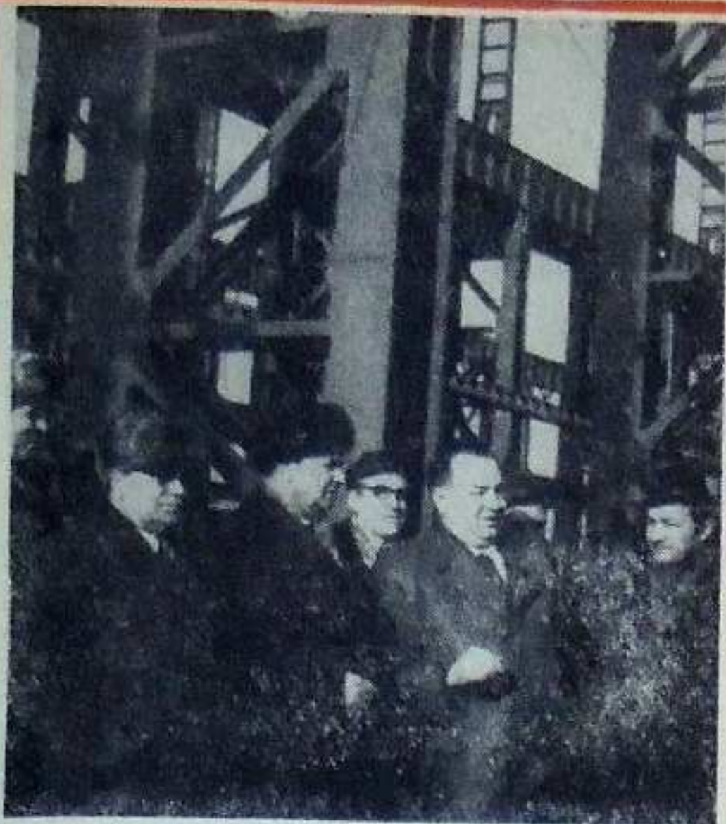
Radzieccy goście na budowie stalowni.
