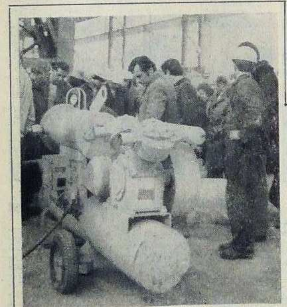
Agregat próżniowego odwadniania betonu
