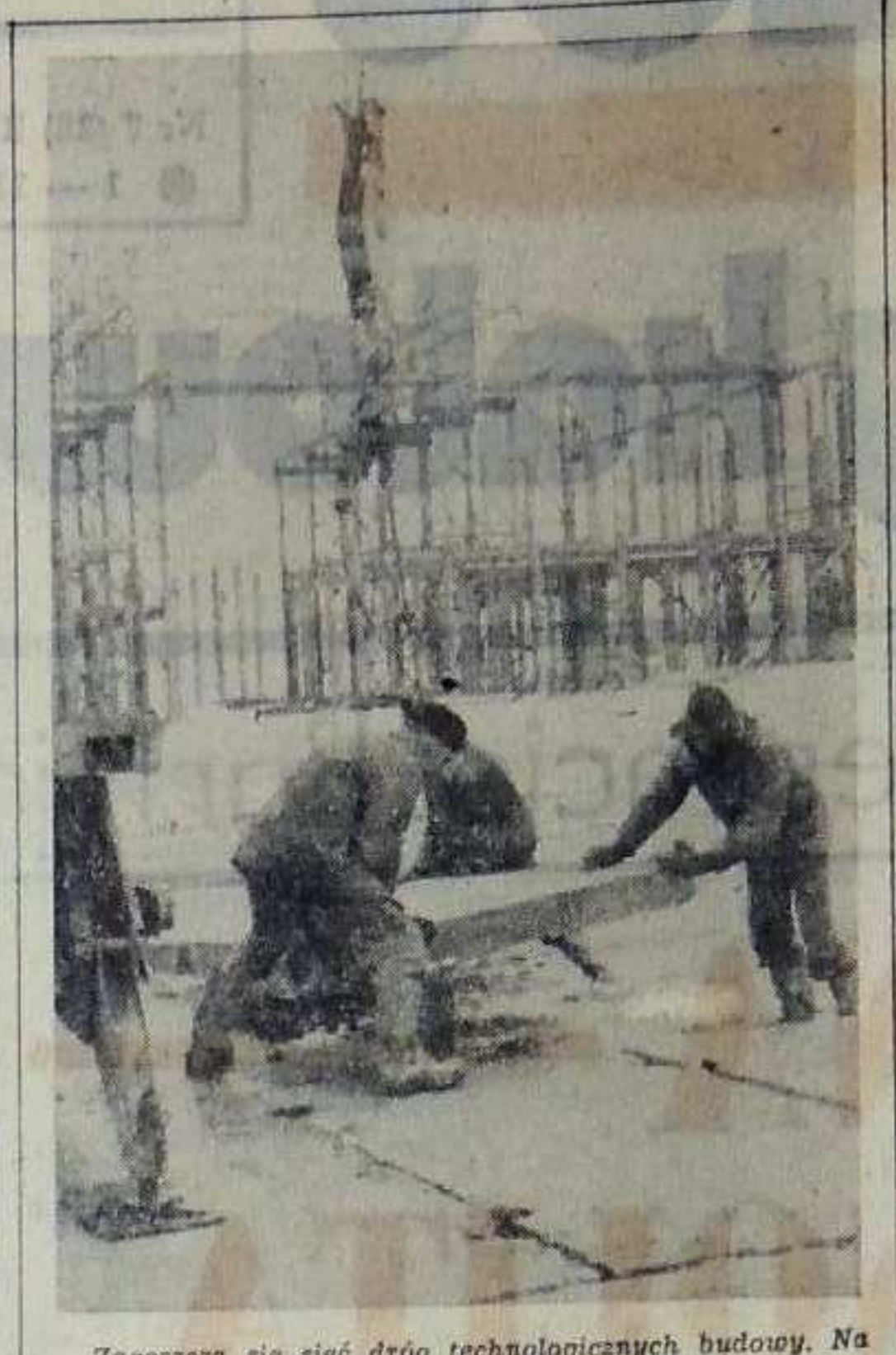
Zagęszcza się sieć dróg technologicznych budowy. Na zdjęciu - układanie drogi w rejonie aglomeracji. ZDJ. J. SAPA
