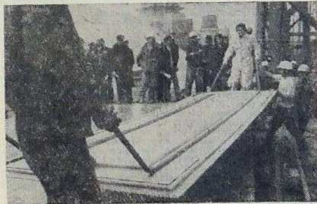
Pokaz działania przenośnych płyt ssących, powodujących dodatkowo zagęszczenie powierzchni betonu.
