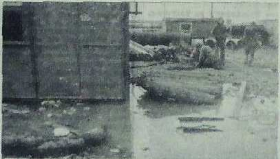
Zaplecze socjalno-bytowe budowy walcowni półwyrobów. W wodzie — butle tlenowe...
