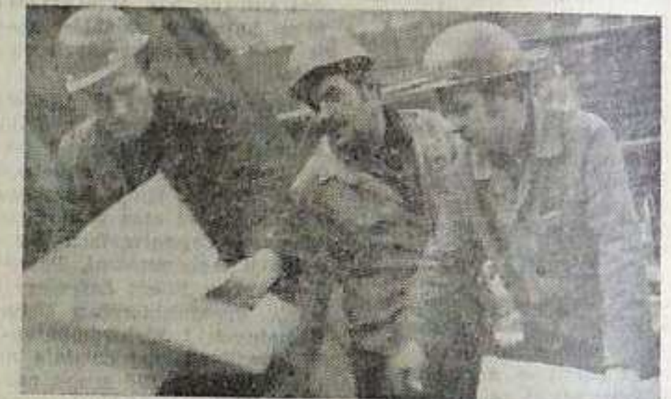
Tadeusz Pawełek wraz z brygadziwą ciesielskim Mieczysławem Jeziornikiem i brygadziwą ślusarsko-montażowym Adolfem Nowakiem omawiają organizację robót przy montażu kanałów technologicznych potężnego fundamentu.
