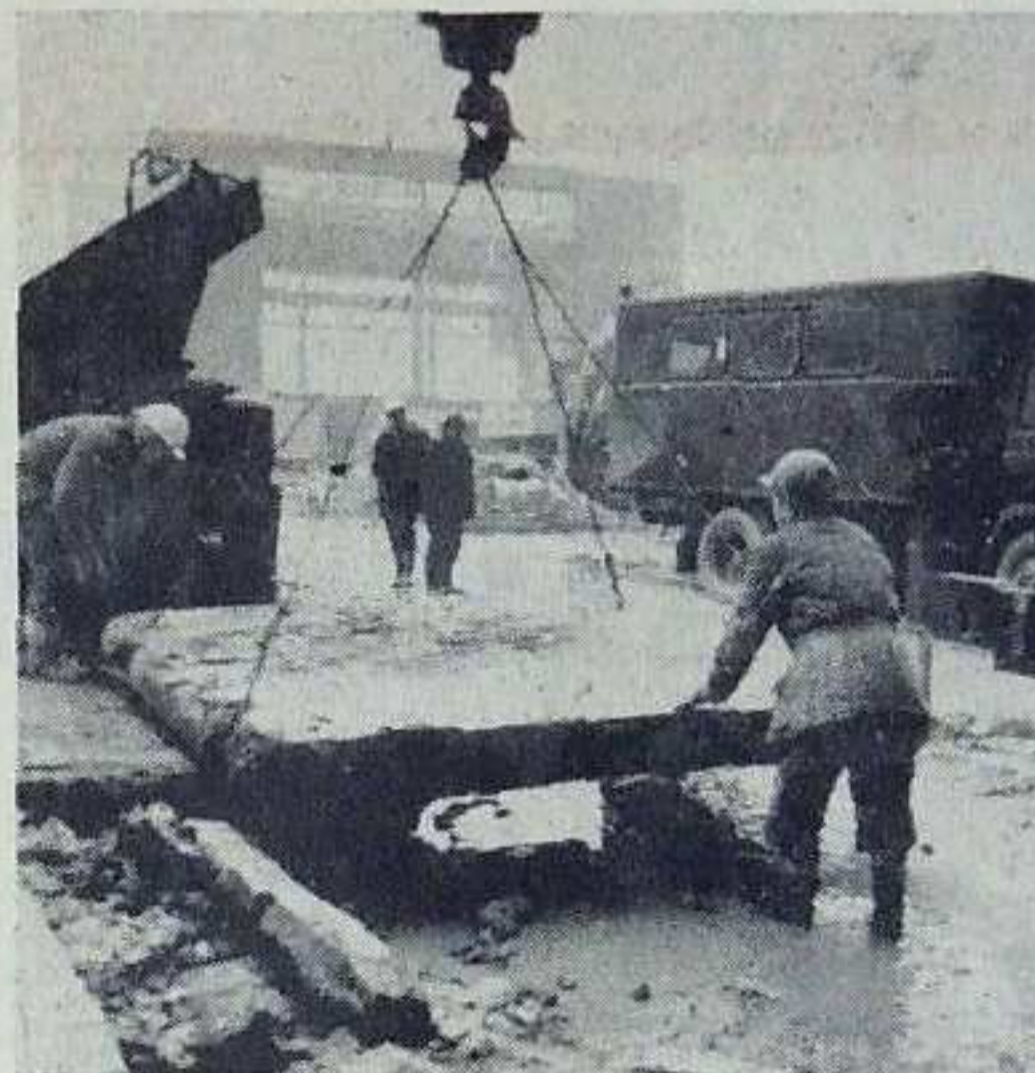
Ekipy drogowe naprawiły szereg odcinków dróg na placu budowy. Ułożono też setki płyt betonowych na nowych odcinkach dróg technologicznych.
