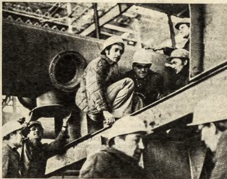
Montaż pieca zapłonowego taśmy spiekalniczej rud odbywa się przy ścisłej współpracy budowniczych i hutników, pod nadzorem specjalistów radzieckich.
