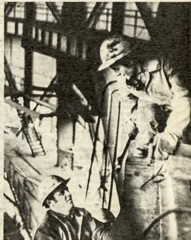
Tadeusz Skrzypek (u dołu) i brygadziśta Jan Góral z krakowskiego Mostostalu wykonują niwelację belek podsuwnicowych w halli lejniczej surówki wielkiego pieca.
