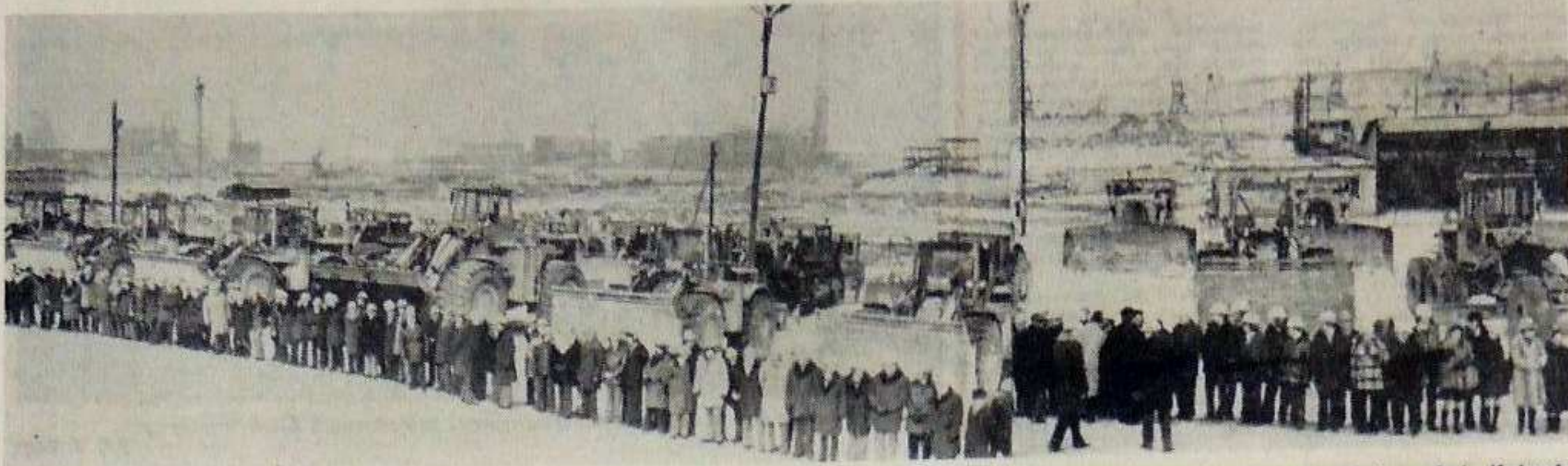
W ubiegłą sobotę załoga Energopolu-3 z Katowic złożyła meldunek o zakończeniu I etapu robót makroinwazyjnych na terenie budowy huty Katowice Zdj. J. Sapa
