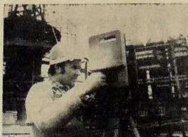
Pracownik gliwickiego Biprohutu, geodeta, Henryk Kotewicz, współpracuje stale z załogą OPGK. Wykonuje pomiar osnowy geodezyjnej z zastosowaniem półautomatycznej rejestracji danych na perforatorze „Geodet” sprzężonym z „Geodimetrem 800”. Uzyskane w ten sposób zapisy są gotowe do wykonania obliczeń na komputerze „Odra 1204”.
