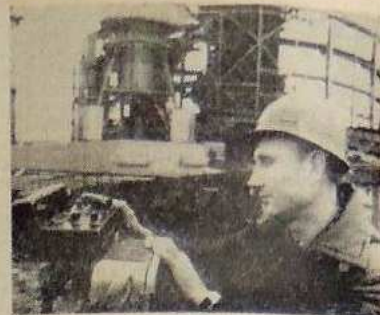
Mgr inż. Edward Stabolepszy wykonywał geodezyjną kontrolę montażu pancera wielkiego pieca poalugując się własnej konstrukcji magnetycznym minireflektorem odbijającym wiązkę światła laserowego na powrót do „Geodimeru 100”.
