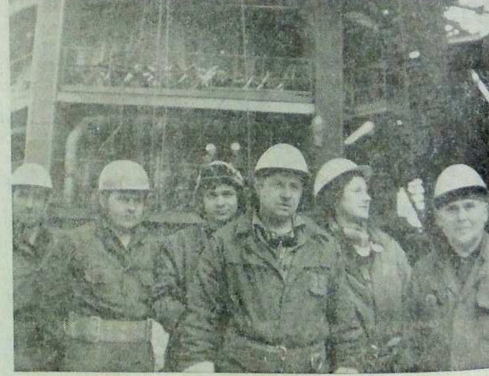
Brygada montażowa konstrukcji obudowy pieca. Od lewej: Jan Krynicki, Józef Kędziela, Ryszard Nawrot, Marian Suski, Zenon Nowosiak i brygadzieta Edward Jelonek.
