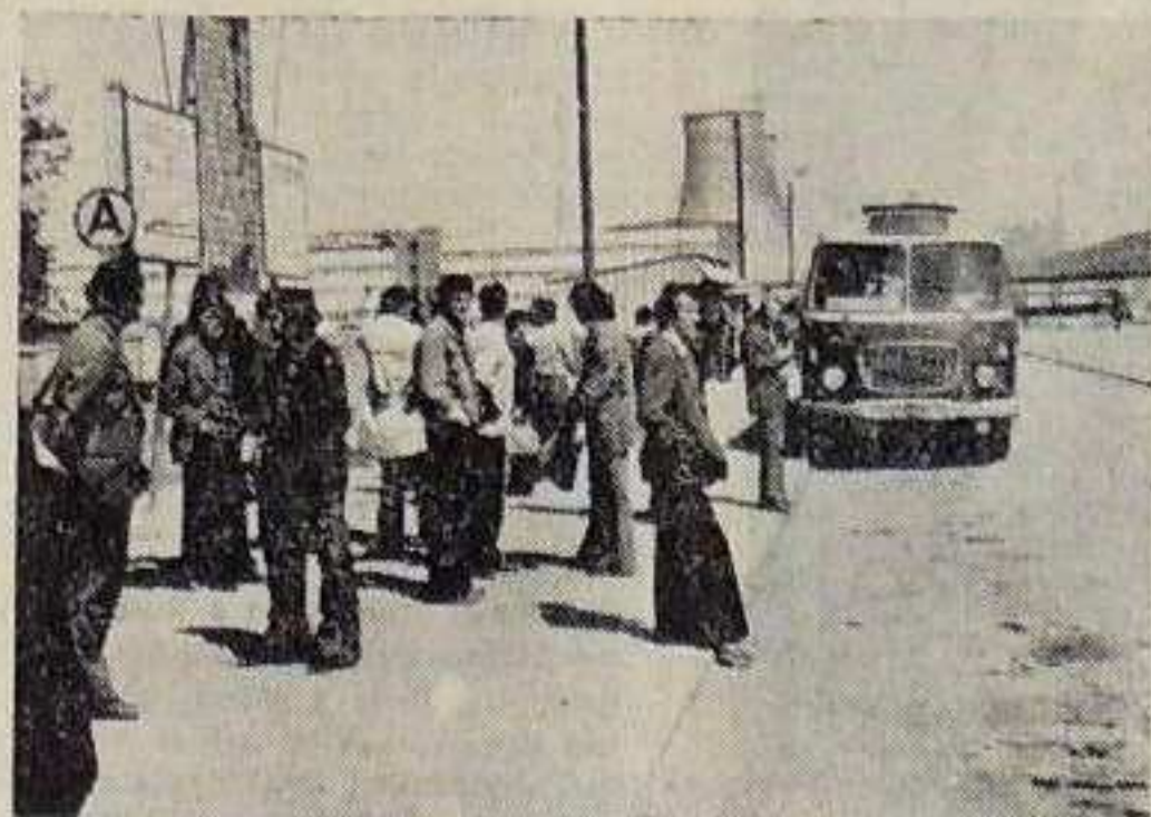
Przystanek autobusowy na budowie Huty Katowice. Codziennie przewożą się tędy kilka tysięcy pasażerów. Zdj. M. Noworyta
