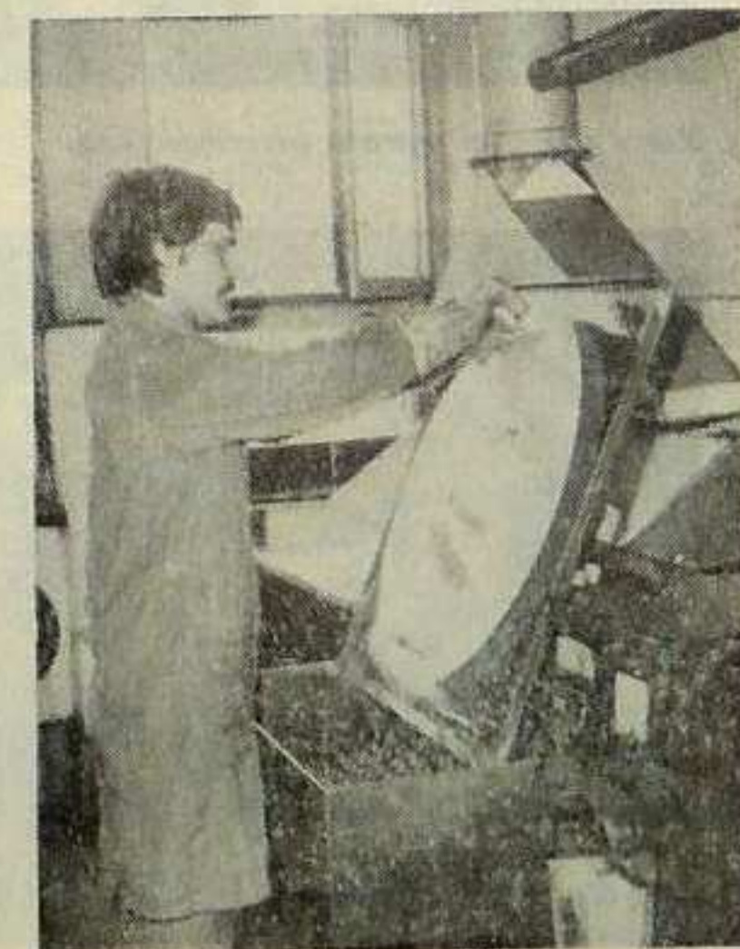
Proces trawienia skończony. Klisze mogą iść do dalszej obróbki. Przy trawiarce Stanisław Szeja.
