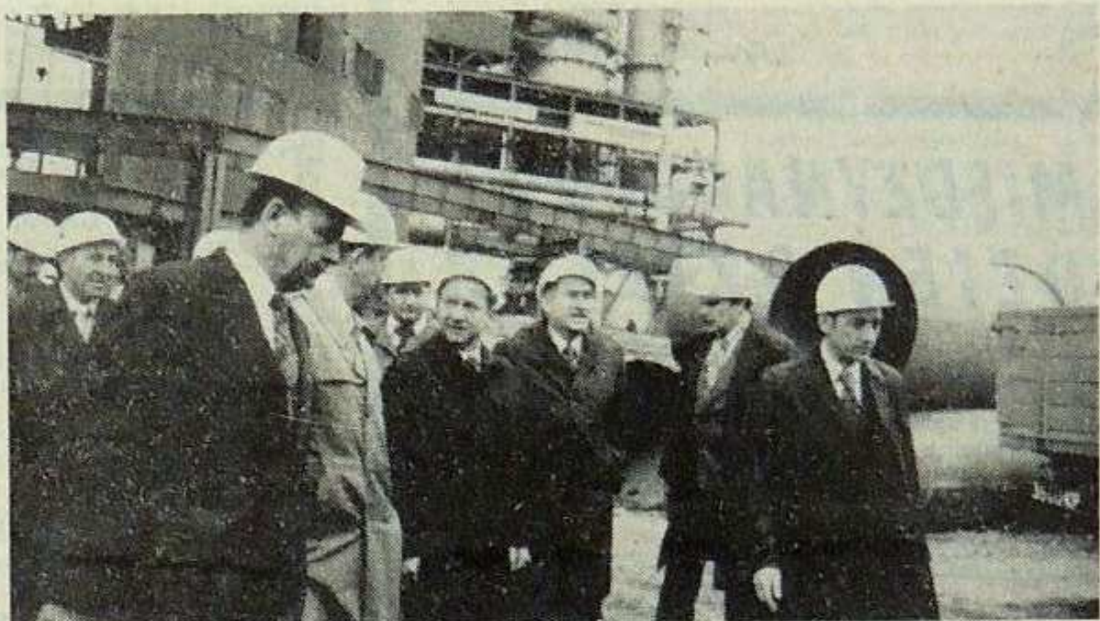
Edward Babiuch i Zdzisław Grudzień zwiędzili w towarzystwie gospodarzy budowy niektóre obiekty leżące na linii stali.
