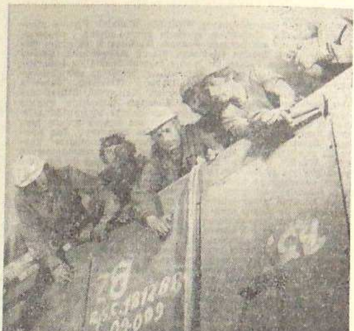
Kilka minut przed północą. Brygada Tadeusza Cieślaka przy montażu osłony wentylatora. Zdj. J. Sapa
