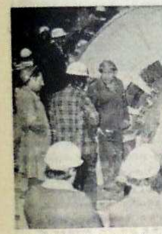
Za kilkadziesiąt minut brygady wykonawcze zameldują o gotowości silnika synchronicznego na walcowni-ogniostawie do uruchomienia.
