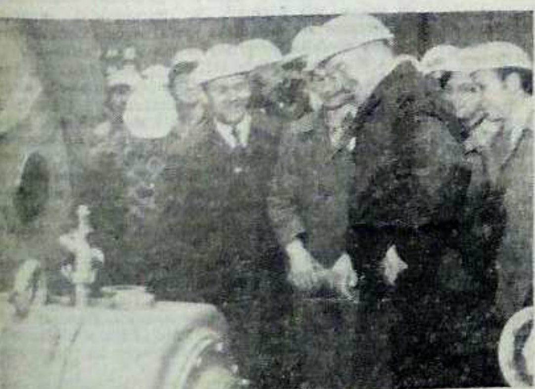
Na obudowie pracującego silnika postawiona została dwudziestogroszówka. Nawet nie drgnęła.
