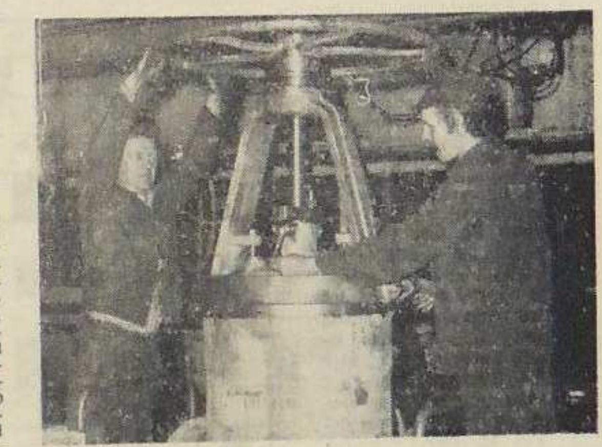
Montaż zasuw klinowej.
