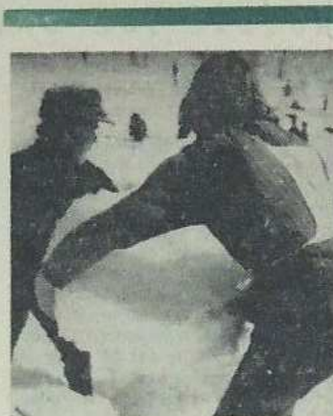
Pracownicy przy budowie obiektu.
