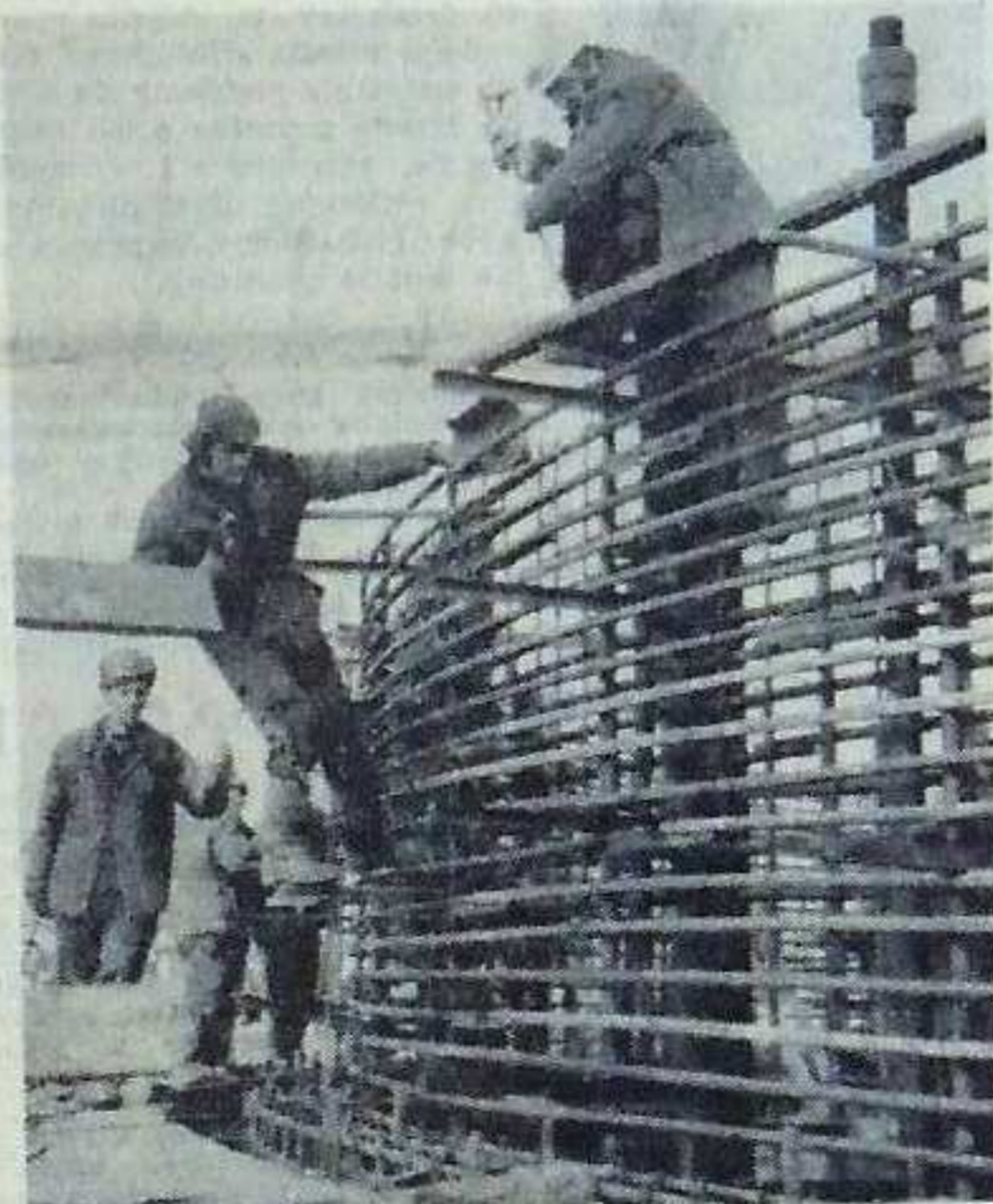
Za chwilę te stalowe zbrojenia zaleje beton.
