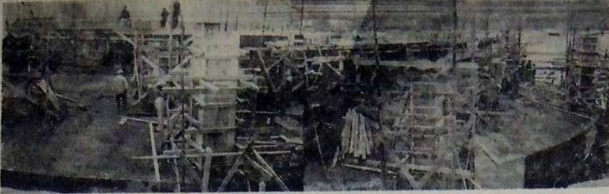
Fundament wielkiego pieca i hali leźniczej.
