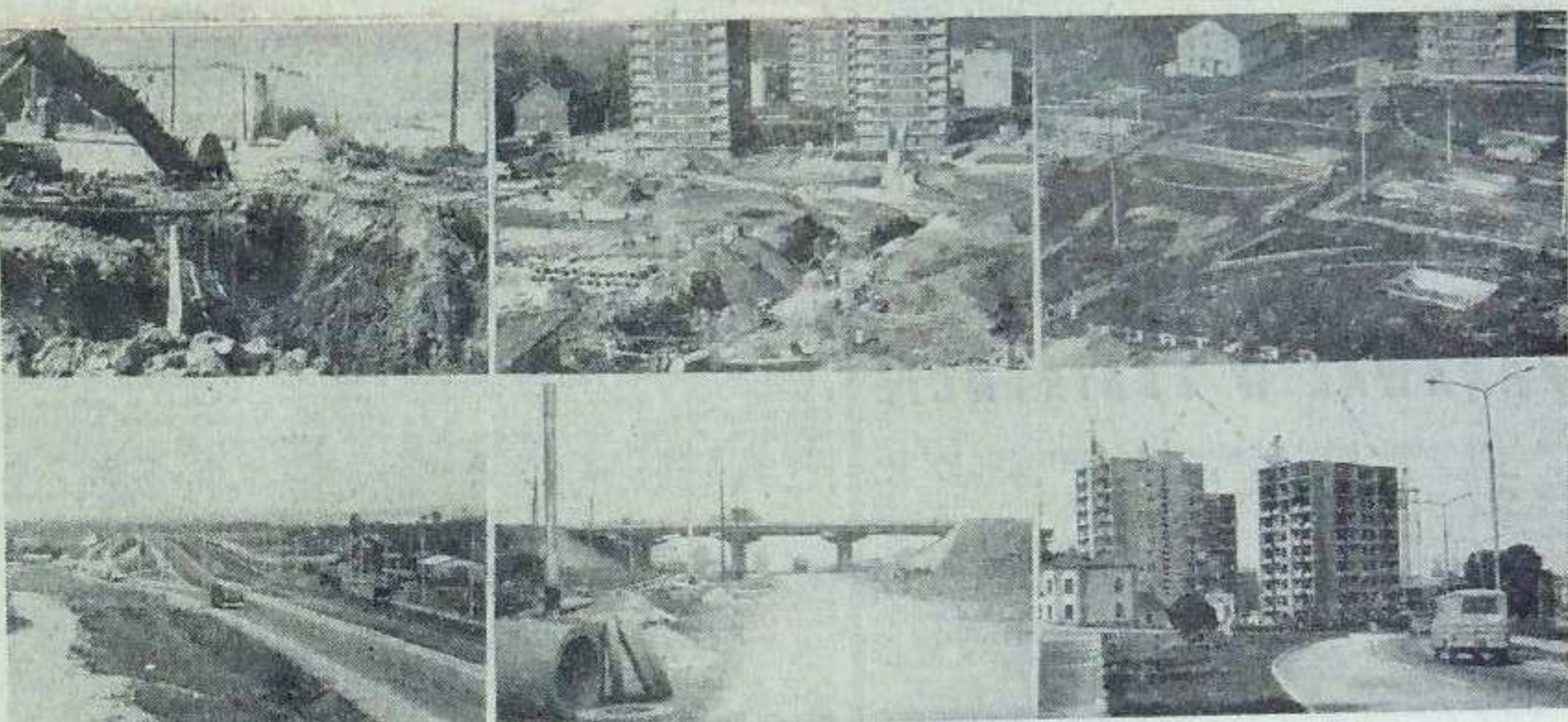
Dąbrowa zmienia się z miesiąca na miesiąc. Bez przesady można powiedzieć, że jest to w tej chwili wielkim poligonem budowlanym. Zdj. X. Górski
