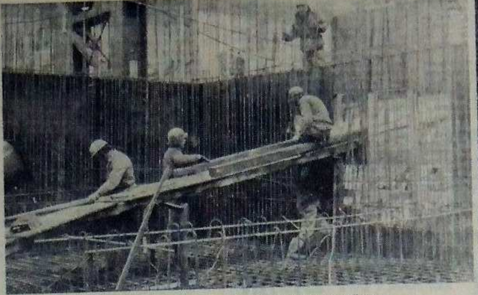
Brygady ZBZT wykonują montaż pochylni do transportu łbetonu.
