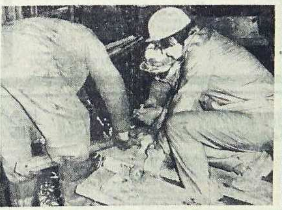
Brygada J. Marka remontuje wywrotnicę wagonową.
