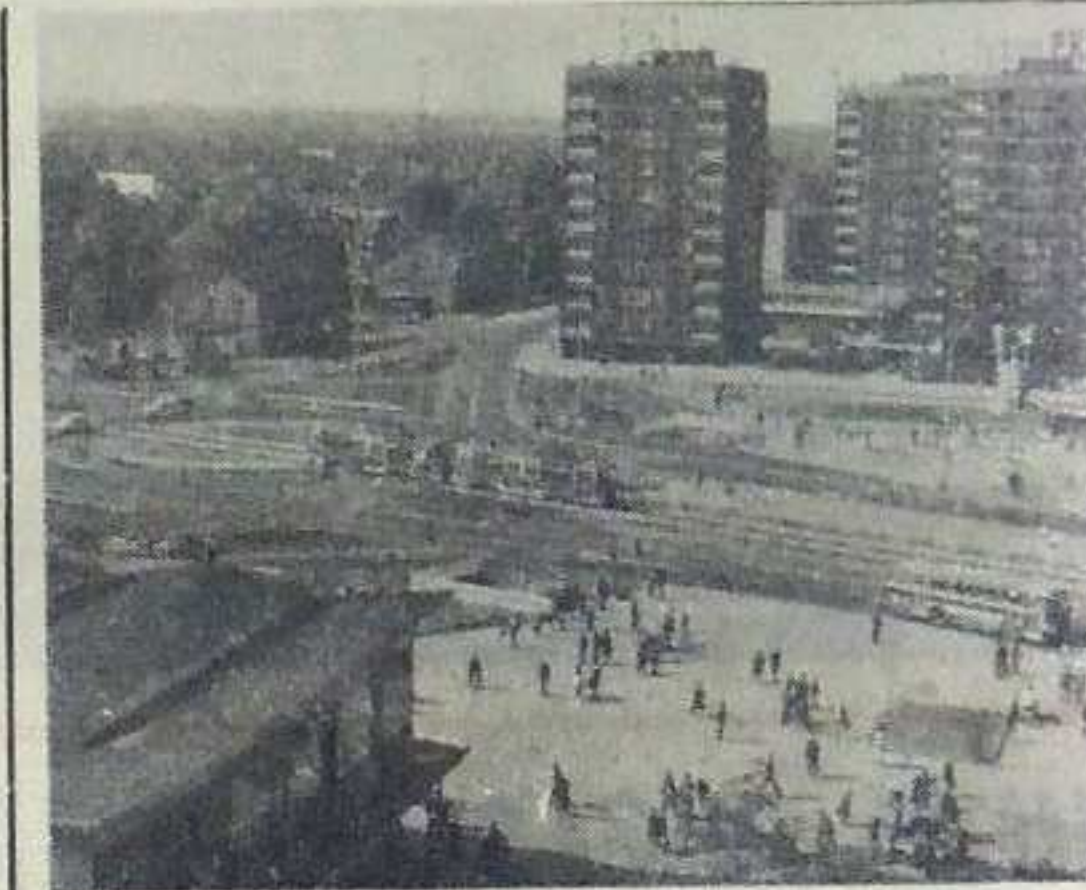
Centralny węzeł komunikacyjny Dąbrowy po przebudowie.
