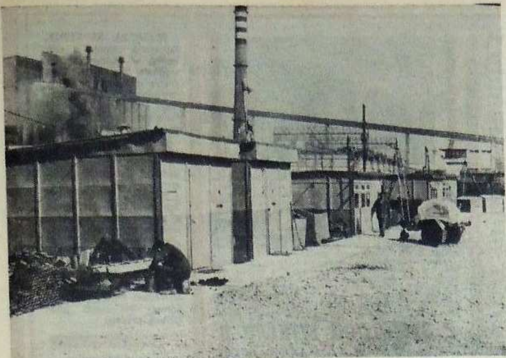
Niestety, nie wszystkie zaplecza wyglądają tak wzorowo, jak zaplecze (na zdjęciu) robót towarzyszących budowy nr 22 PRI Dąbrowa Górnicza. Kierownikiem jest tu Piotr Oleszczyk. Zdj. X. Górak
