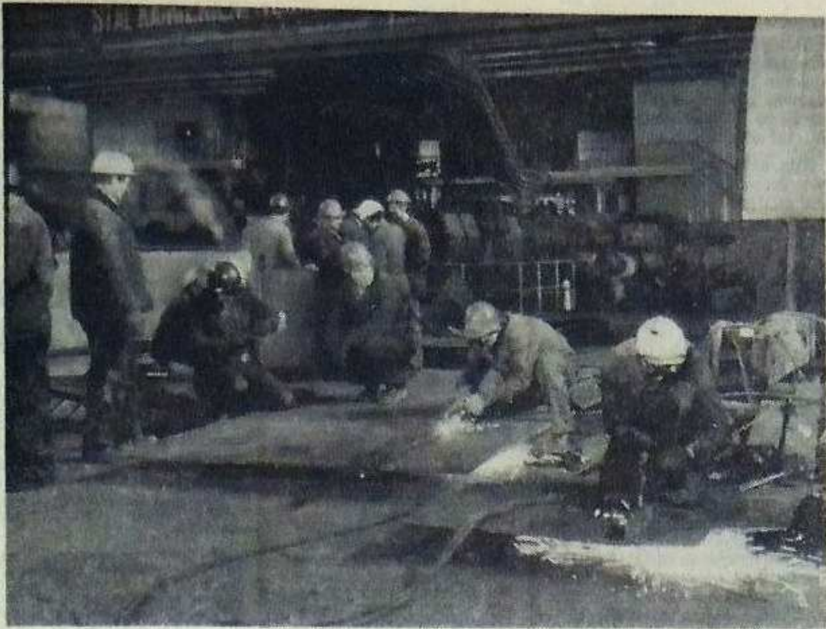
Na walcowni-ogniatocu przeprowadzono ostatnio szereg prac w ramach planowanych remontów. Zdj. X. Górak
