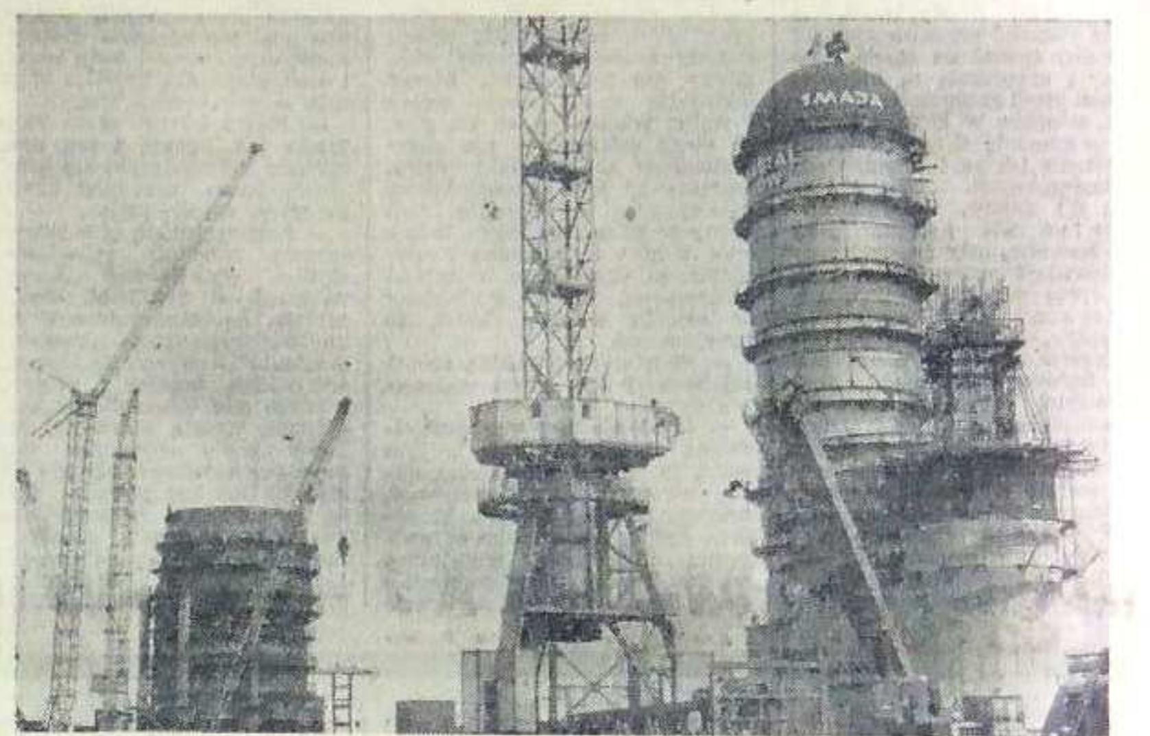
Tak wyglądał jeszcze w maju rejon budowy wielkiego pieca nr 2. To zdjęcie jest już archiwalne. Zdj. X. Góról
