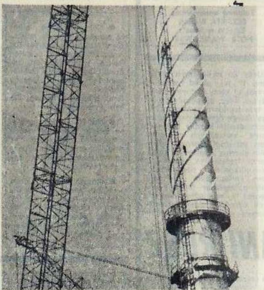
Stalowe konstrukcje przybierają często niezwykle oryginalne kształty. Zdj. P. Wasikowski
