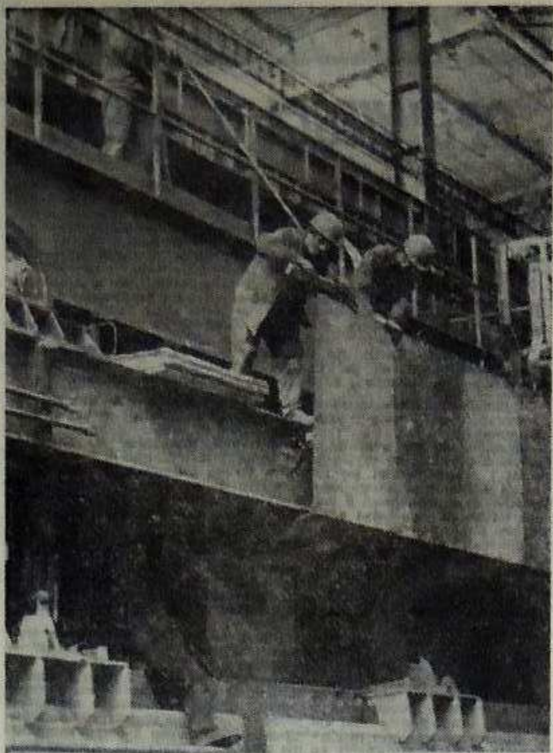
Ostatnie prace przy piecu grzewczym.
