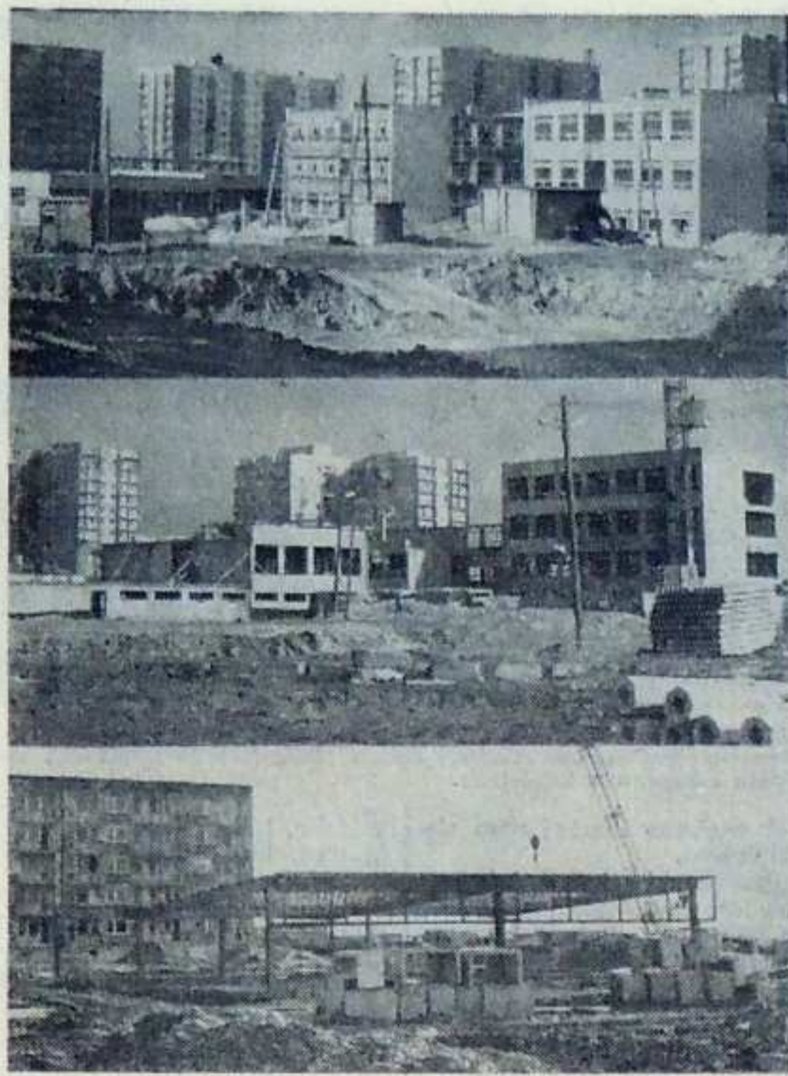
Górne zdjęcia przedstawiają budowę zespołów oświatowych osiedli A-B i C1 - C4 w Zagórze. Na zdjęciu dolnym — gotowa konstrukcja pawilonu handlowego między osiedlami C2 i C3 również w Zagórze.
