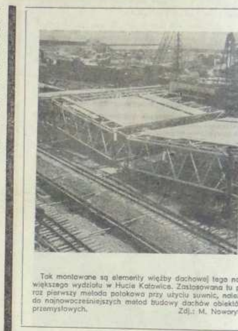
Tak montowane są elementy więzby dachowej tego największego wydziału w Hucie Katowice. Zastopowana tu po raz pierwszy metoda polokowa przy użyciu suwnic, należy do najnowocześniejszych metod budowy dachów obiektów przemysłowych. Zdjęcie: M. Noworyta
