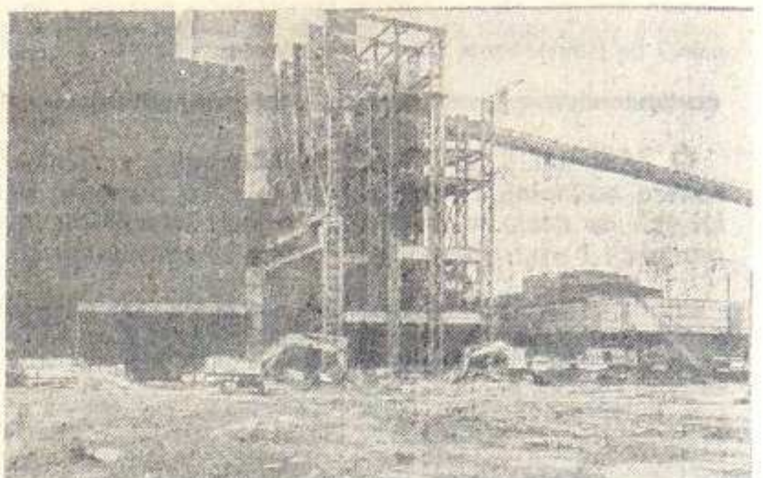
Konstrukcje hali trzeciego konwertora.
