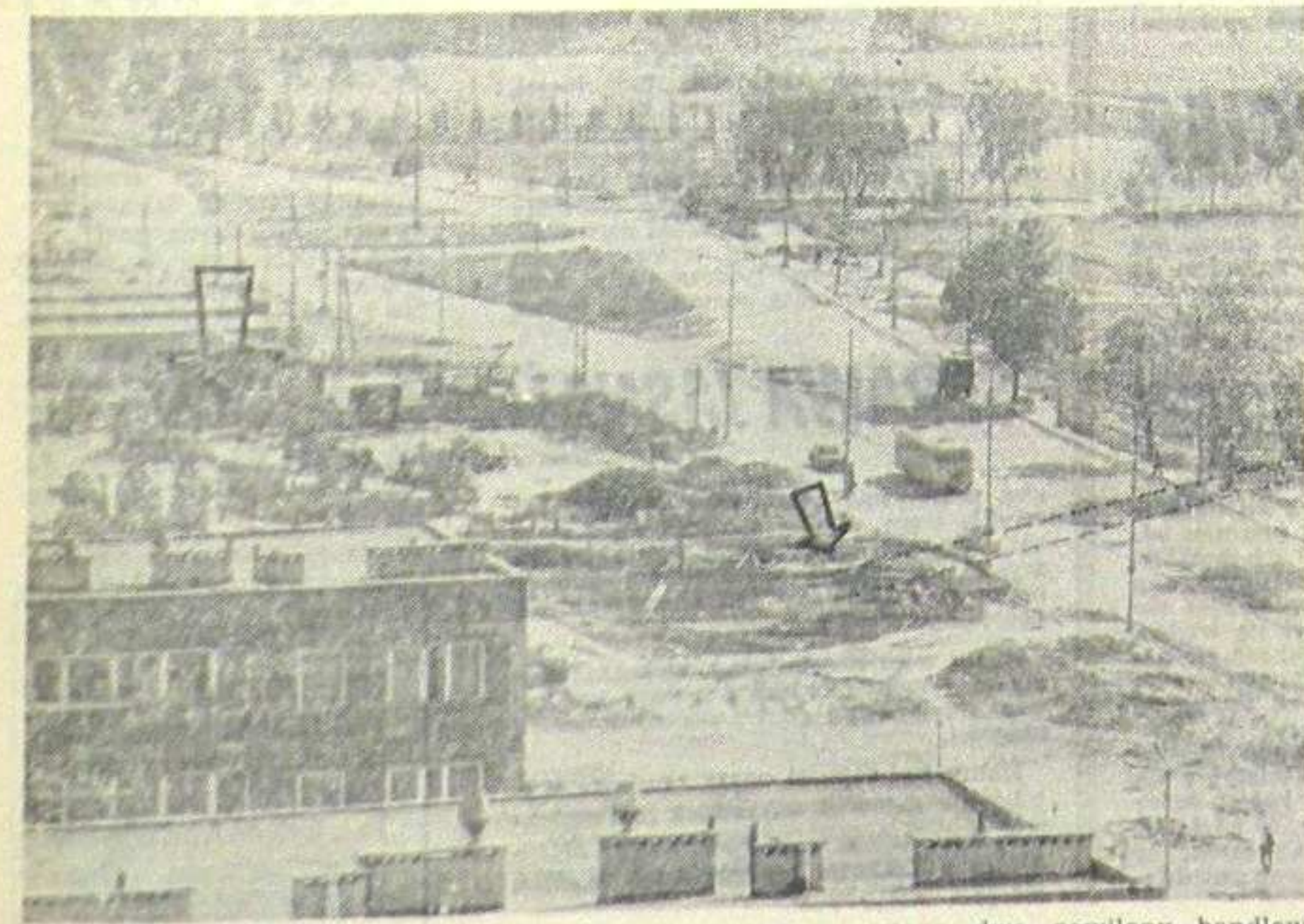
Szalka większa pokazuje miejsce w którym wzniesione zostaną dwa pawilony handlowe, oszywiście po wyprowadzeniu się budowlanych. Szalka mniejsza i linie przerywane usytuowane w miejscu gdzie w tym roku powstaną jedno z dwóch przejść podziemnych.
