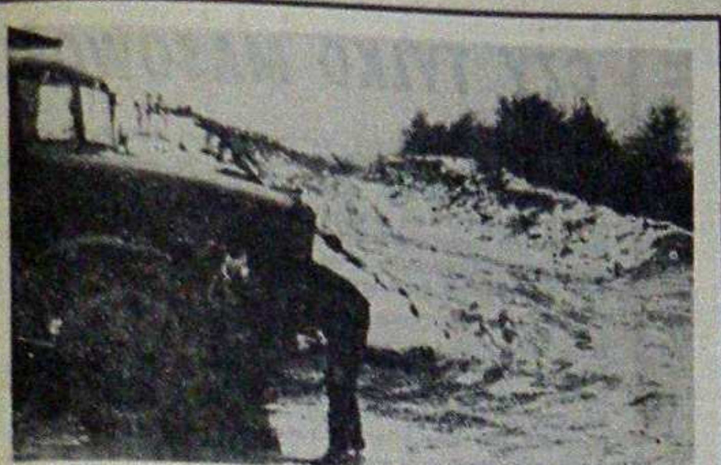
Budowa Lini Hutniczo-Starkowej. Tędy w przyszłości pobiegnie największa magistrala kolejowa dostarczająca do Huty Katowice ruć ze Związku Radzieckiego.
