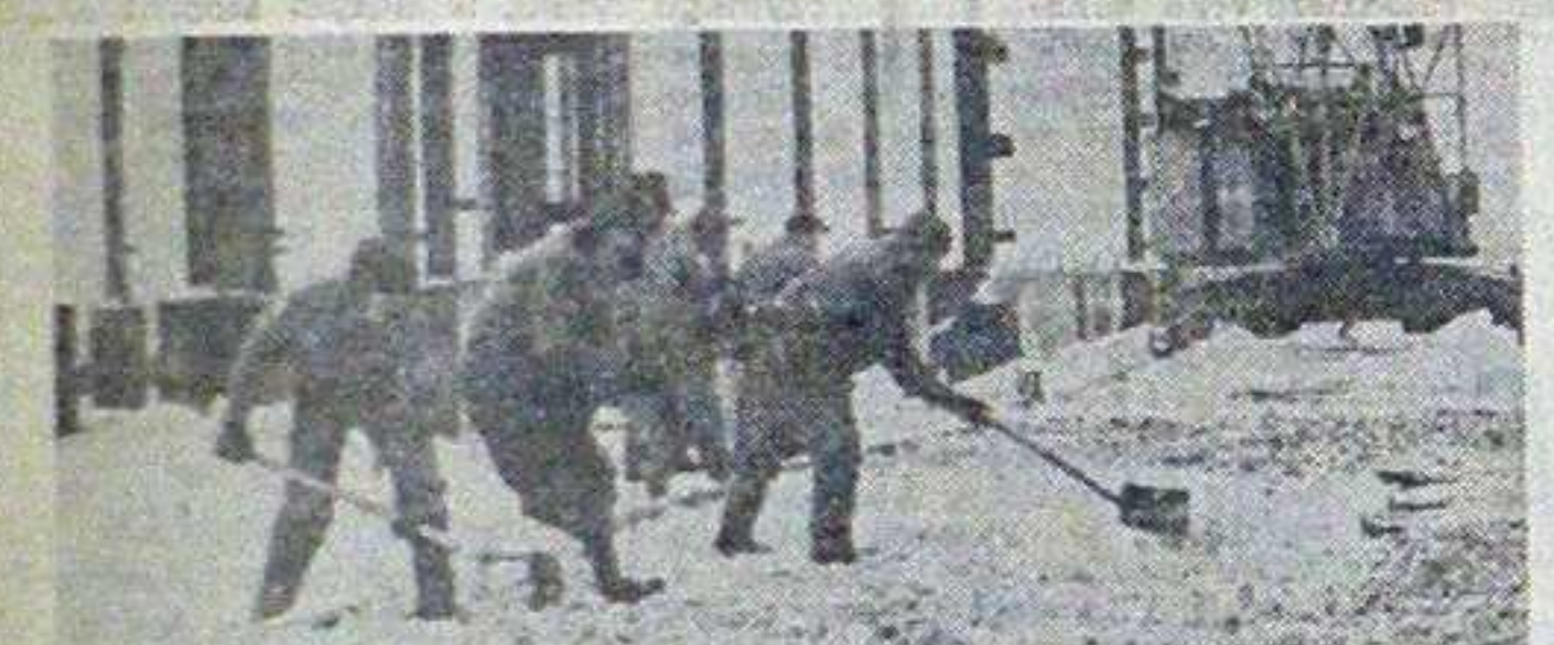
TRADYCYJNIE JUŻ w realizacji trudnych zadań budowlanych pomagają żołnierze Ludowego Wojska Polskiego. Podobnie jest w przypadku budowy Lini Hutniczo-Starkowej oraz jej końcowej stacji — bazy przeładunkowej rud. Każdego dnia na placu budowy obiektów bazy staje kilkadziesiąt żołnierzy zgromadzonych w Strzemieszycach. W trudnych warunkach atmosferycznych wykonują oni prace ziemne, ciesielskie i montażowe.
