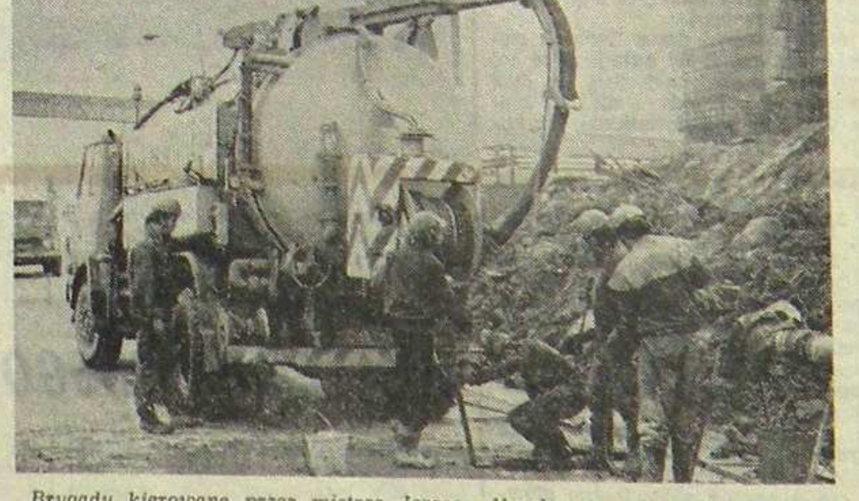
Brygady kierowane przez mistrza Jerzego Mączkę, przy pomocy urządzenia typu MUT, dokonują czyszczenia kolektora Ks-1 w rejonie aglomeracji. Zdj. P. Wąsikowski
