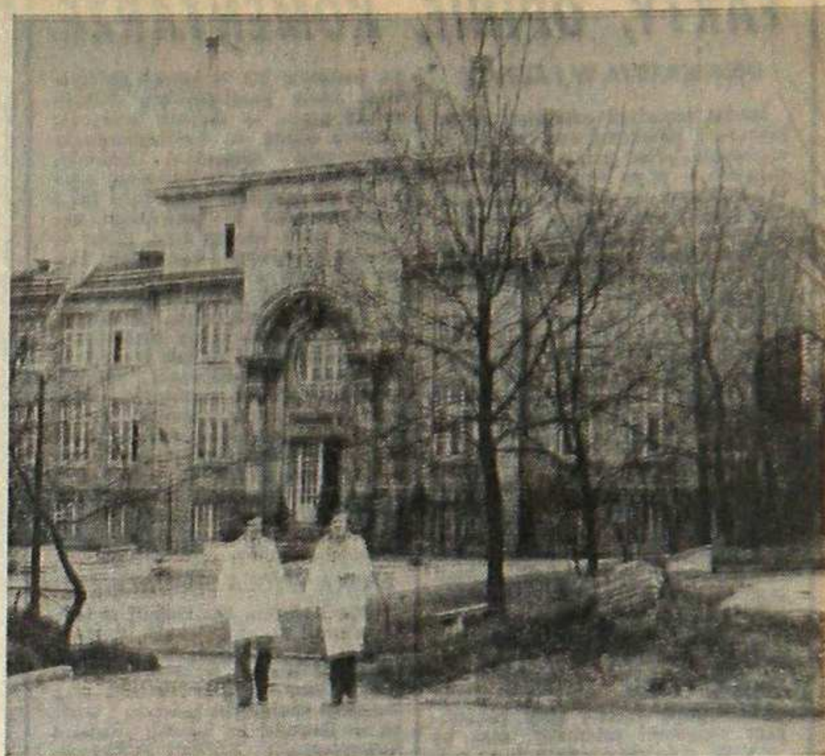
Gmach Wydziału Hutniczo-Mechanicznego Politechniki Śląskiej w Dąbrowie Górniczej. fot. P. Wąsikowski
