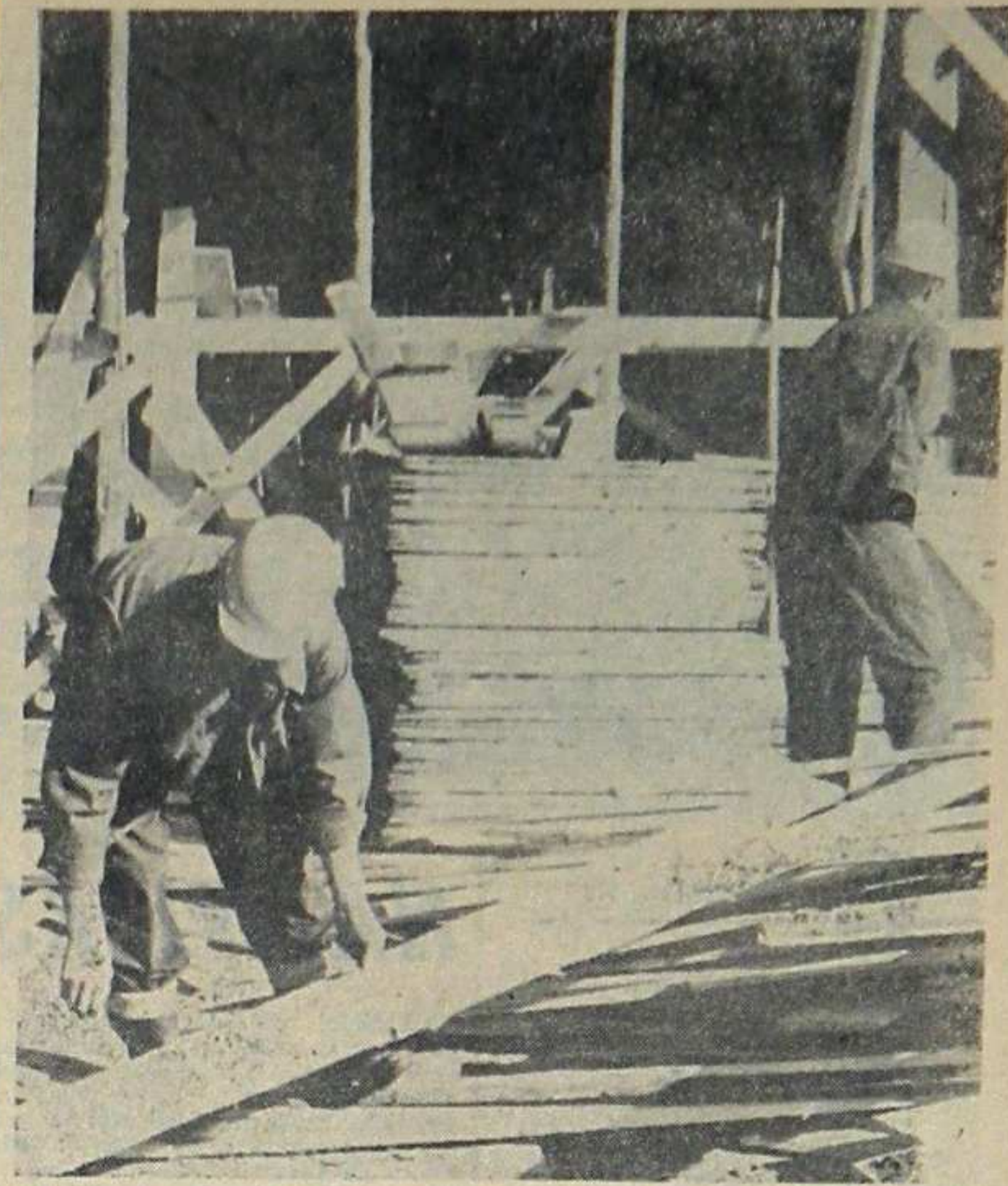
Na naszych budowach drewno nadal niestety pozostaje niezastąpionym materiałem ciesielskim.
