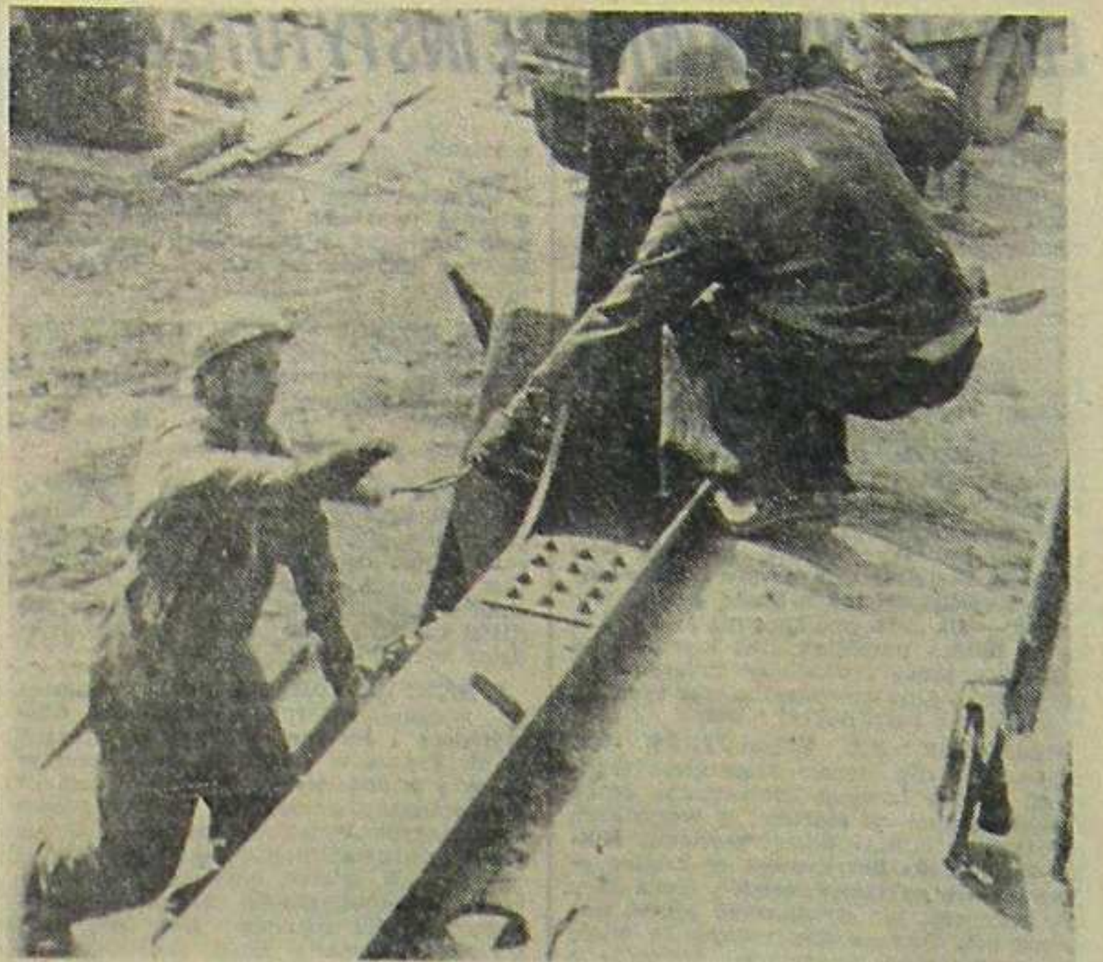
Budowniczo LHS pracują szybko. Do uzyskania pierwszej przejezdności linii pozostało niewiele dni.
