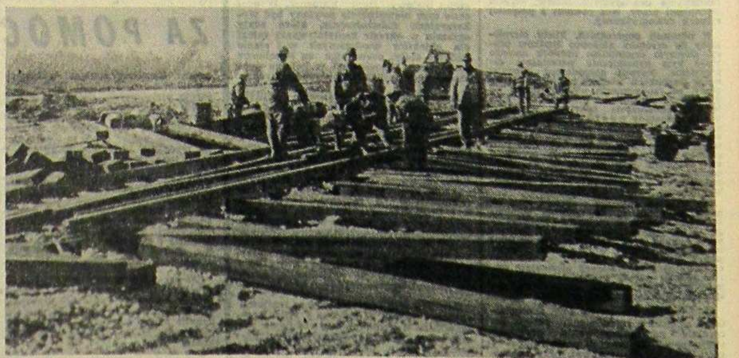
Tor łączący końcówkę Lini Hutniczo-Starkowej z wywrotnicą wagonową bazy ma długość 4,6 kilometra. Wykonuje go załoga Krakowskiego Przedsiębiorstwa Robót Inżynierskich. Każdego dnia wysypuje się na torowisko ponad 2 tys. ton tuczni, z dostawą którego występują czasowe trudności.
