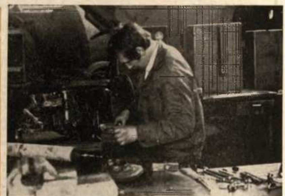
Wypisał napraw fabryki samochodowego S-48. Andrzej Pachor przy naprawie skrzyżni biegów samochodu „Star”.
